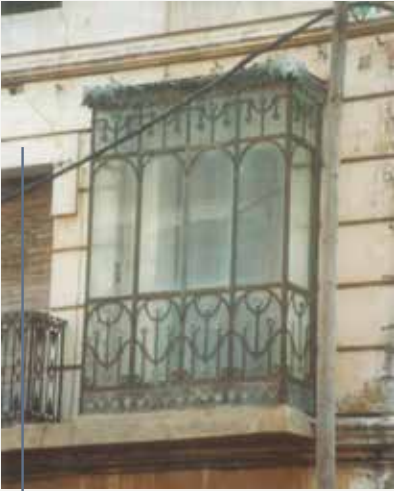
Mirador. Detalle de la fachada de la casa de Pepe Sanz
